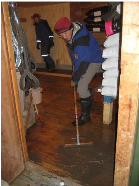
Før-rommet vaskes og nye hyller settes opp etter vegg- og takreparasjoner.
